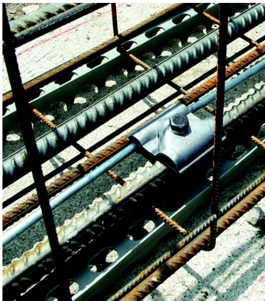
コンクリートに埋め込まれた導体の接続
